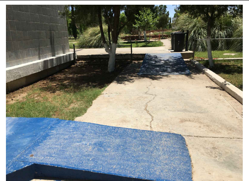
rd3-4,RA4.-RAMPA A DEMOLER
