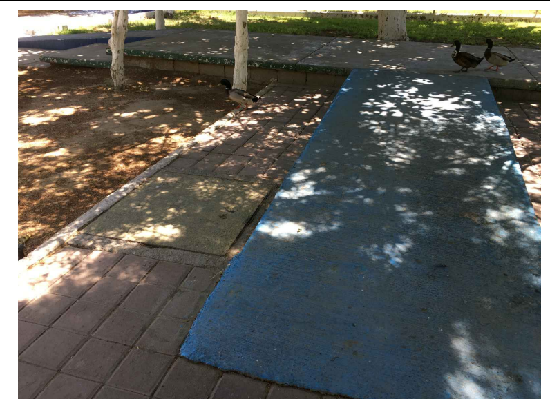
rd1.-RAMPA A DEMOLER
