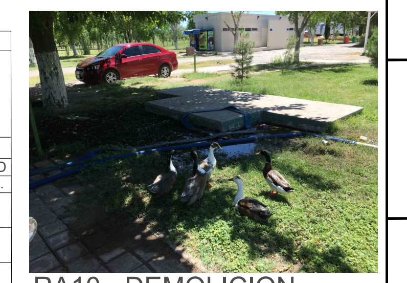
RA10.- DEMOLICION DE FIRME DE CONCRETO
