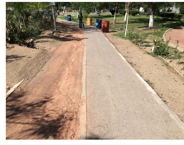
D1.-DEMOLICION DE CORREDOR
