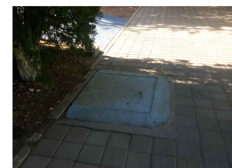
R.-RESTAURACION DE REGISTRO
