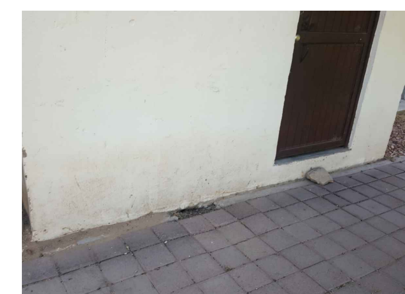
CB7.-COLADO DE BORDILLO
