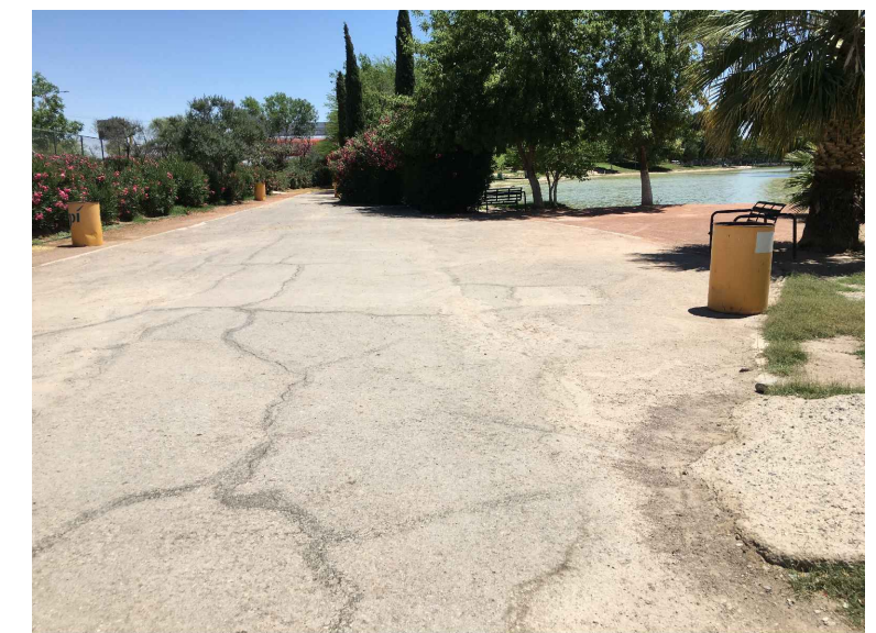
CB5.-COLADO DE BORDILLO
