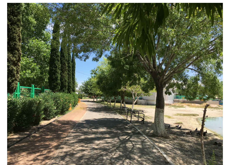
RB,CB2.- RETIRO Y COLADO DE BORDILLO
