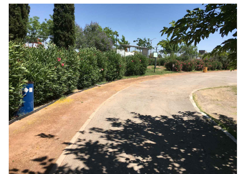
RB,CB4.- RETIRO Y COLADO DE BORDILLO
