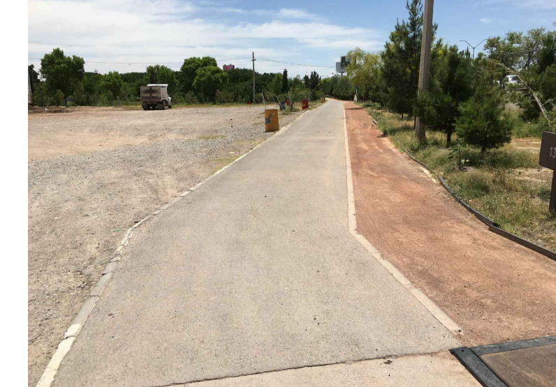
RB, CB1.- RETIRO Y COLADO DE BORDILLO
