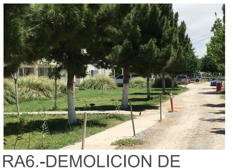
RA6.-DEMOLICION DE FIRMES
