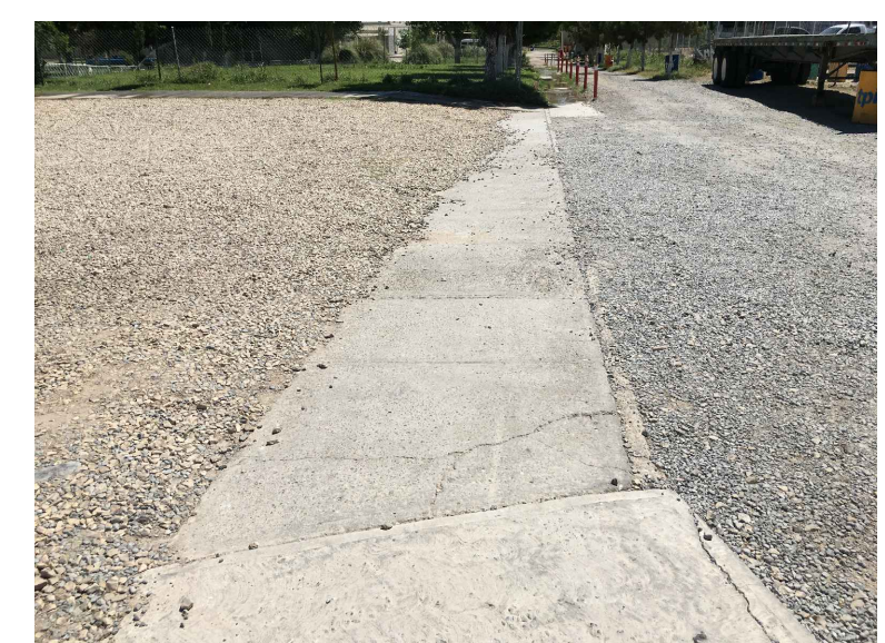
RA3.-DEMOLICION DE FIRMES
