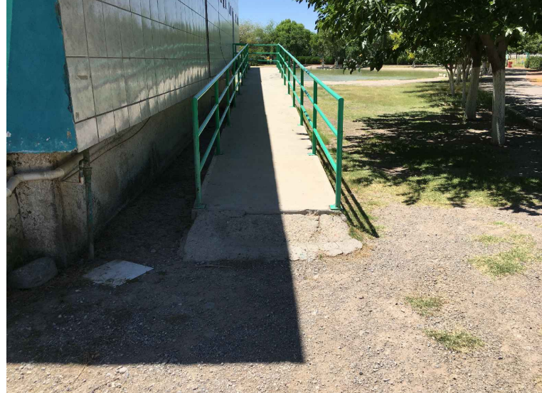
AR1.-DEMOLICION DE FIRME DE CONCRETO
