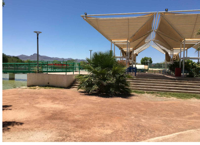
RA4.-RETIRO DE ARCILLA
