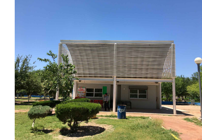
MP1,F2.- FACHADA ORIENTE KIOSKO 2
