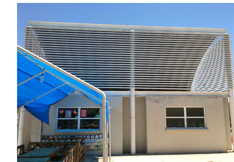
MP1,F4.- FACHADA PONIENTE KIOSKO 2
