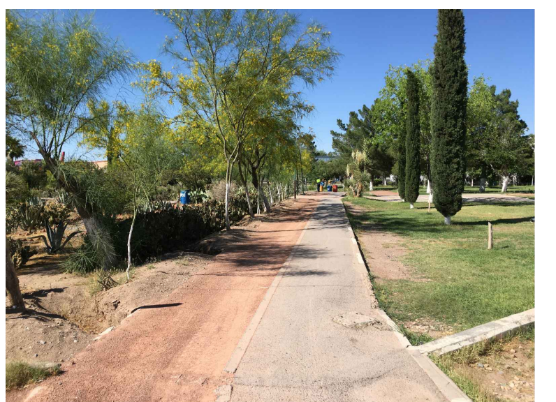
RB, CB2-4.- RETIRO Y COLADO DE BORDILLO
