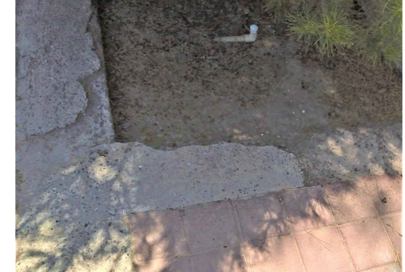
RA-DC6.-RETIRO DE ADOQUÍN Y DEMOLICIÓN DE CENEFAS
