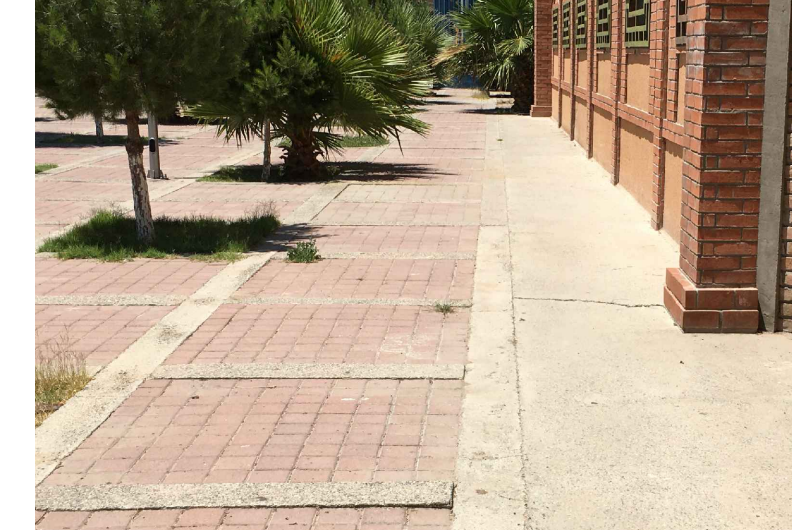
RA14, 15 DC13.-DEMOLICIÓN DE CENEFA Y RETIRO DE ADOQUÍN
