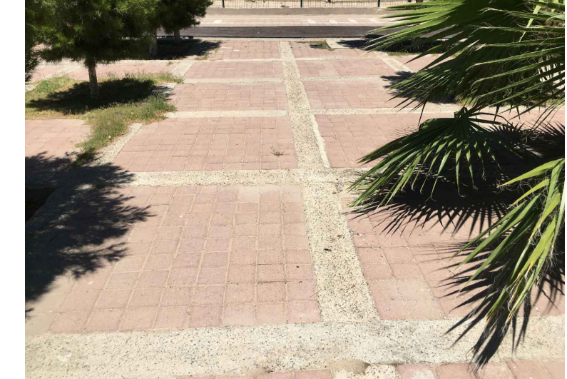
RA,DC12.-RETIRO DE ADOQUÍN Y DEMOLICIÓN DE CENEFAS
