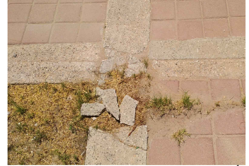
RA-DC8.-RETIRO DE ADOQUÍN Y DEMOLICIÓN DE CENEFAS
