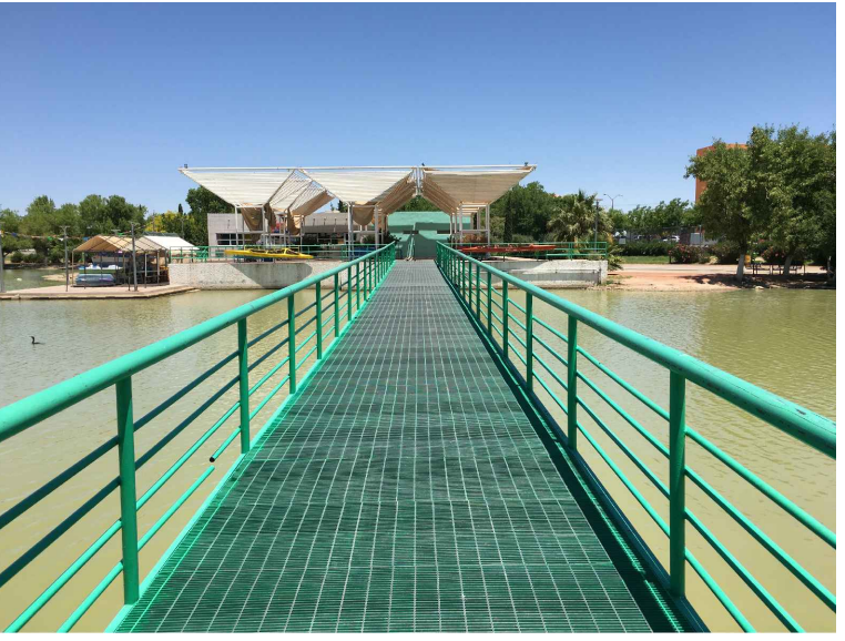
bp,rdb.-BARANDAL PUENTE REPARACION DE BARANDAL
