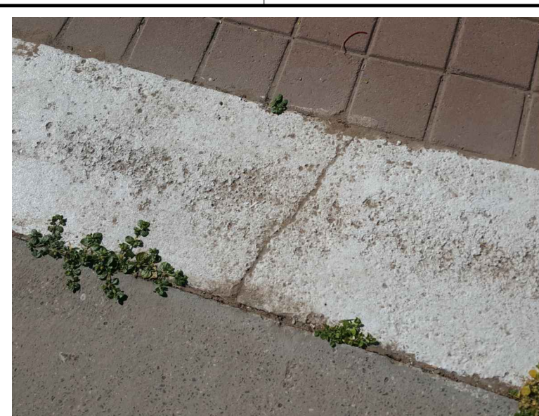
LR1.-GRIETA EN CONCRETO LAVADO
