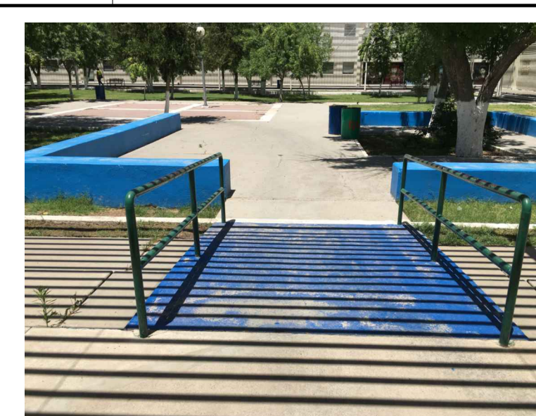
BT2.-BARANDAL TUBULAR rd1.-PINTURA EN RAMPA
