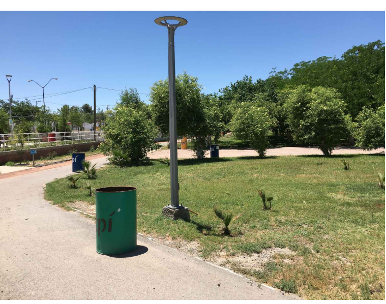
RB,CB2.- RETIRO Y COLADO DE BORDILLO
