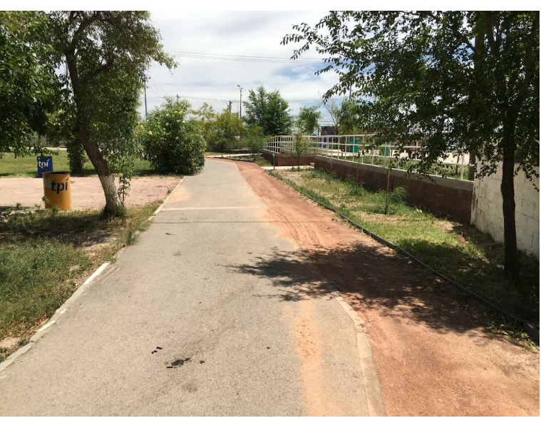
RB,CB3.- RETIRO Y COLADO DE BORDILLO
