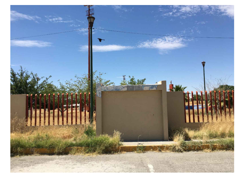
PA. POSTE DE ALUMBRADO
