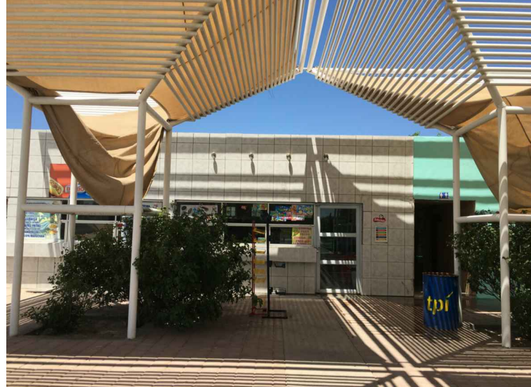
F3.-FACHADA SUR TIENDA
