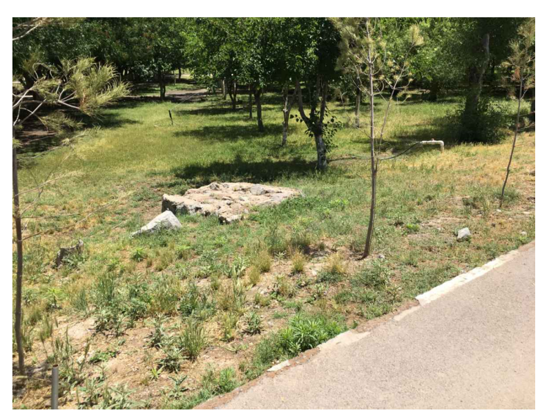
RA2.-DEMOLICIÓN DE MACIZO DE MAMPOSTERÍA
