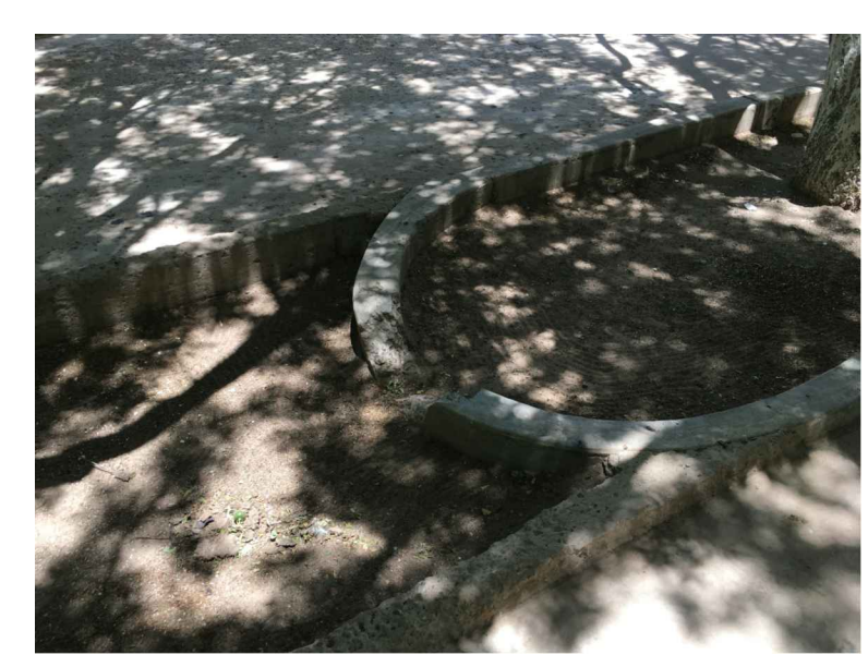
RB7.-RETIRO DE BORDILLO DE CONCRETO
