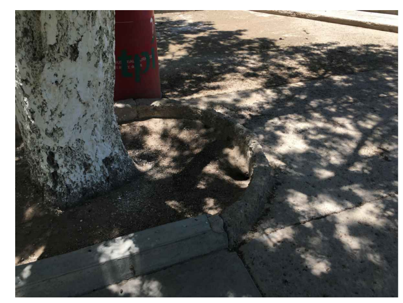
RB6.- RETIRO DE GUARNICIÓN DE CONCRETO
