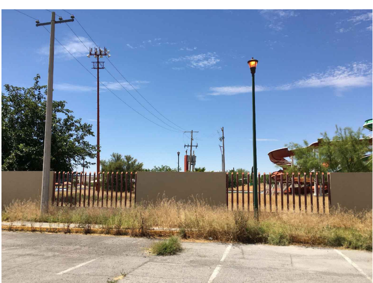
PA. POSTE DE ALUMBRADO
