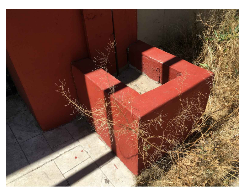
1. RETIRO DE ELEMENTO DE CONCRETO
