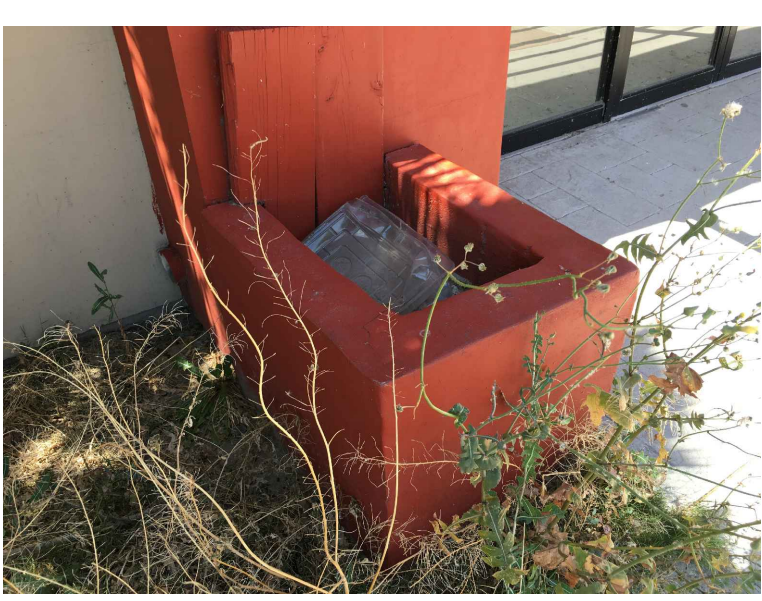
1. RETIRO DE ELEMENTO DE CONCRETO
