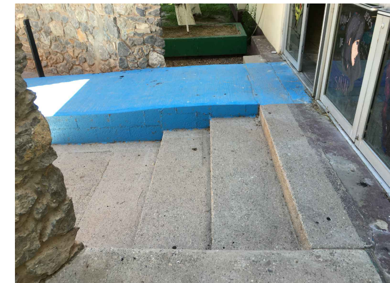
RA3.-DEMOLICION DE FIRME DE CONCRETO
