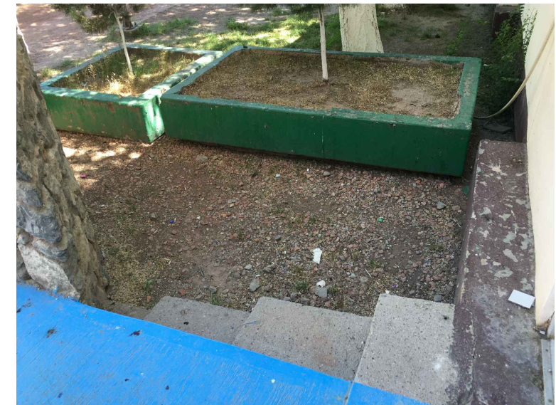
dj.-DEMOLICION DE JARDINERA
