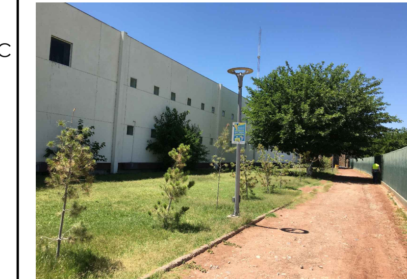
RA1, RB.-DEMOLICION DE BORDILLO Y RETIRO DE ARCILLA
